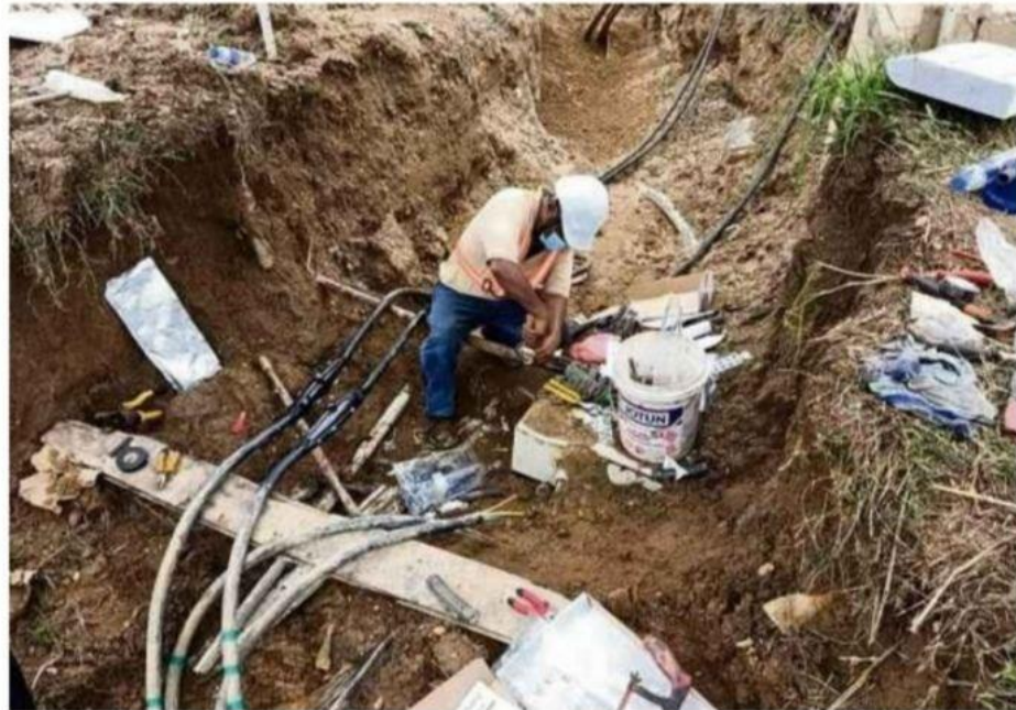
Kerja membaiki dan membuat penyambungan kabel di Telaga HCW no 2 di Semuba, Kelar, sedang giat dilaksanakan semalam.
