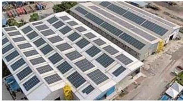
Pemasangan panel solar photovoltaic bumbung terbesar bagi operasi limbungan MMHE West, di Pasir Gudang, Johor. (Foto ihsan MHB)
