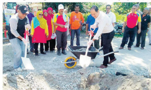
Rosli (kiri) dan Nik Mohd Fariz menggali tanah bagi kerja-kerja pembinaan longkang di Kampung Baru Kerteh Zon 3.
