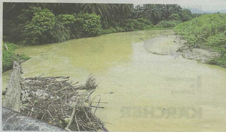
Aliran sungai yang terhalang dengan sampah sarap dikenal pasti punca sistem perparitan di Kampung Juntai tersumbat.
