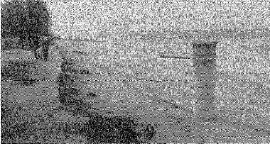
Kedudukan gelung simen sebuah perigi yang kelihatan akibat hakisan di Pantai Pangkalan Maras.
