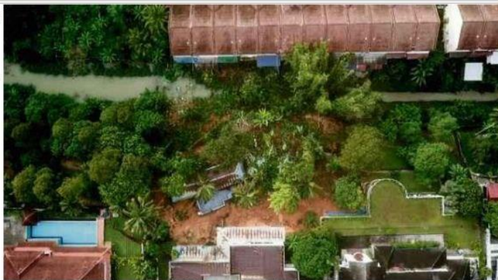
Keadaan kawasan kejadian tanah runtuh di Kemensah Heights, Hulu Klang.
