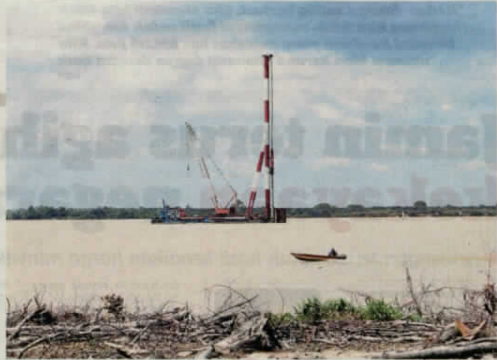
KERJA pembinaan jambatan baru Bagan Datuk ke Kampung Sejongop mula diumumkan pada 3 Julai tahun lalu.
