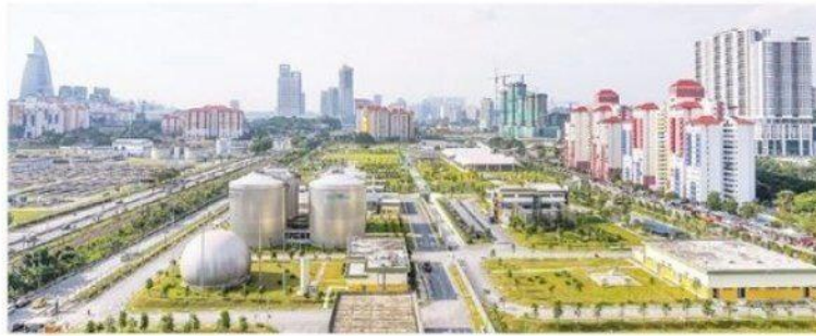
Loji Rawatan Kumbahan Serantau Pantai 2 (RSTP2) yang direka dengan kapasiti untuk merawat 1.423 juta populasi setara atau 320 juta liter efluen terawat sehari.
