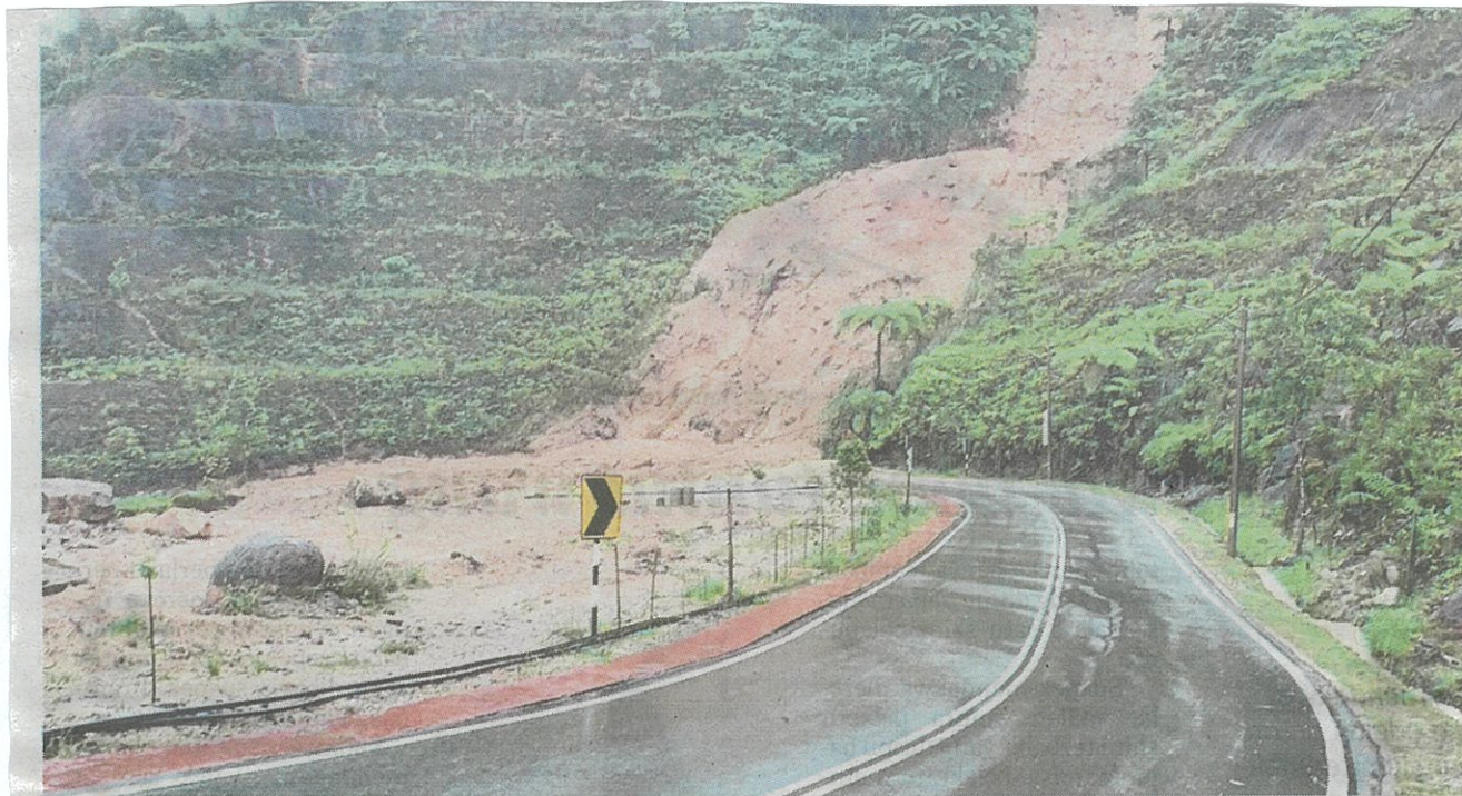
† LALUAN di Jalan Ion Delemen yang tersekat akibat tanah runtuh.
